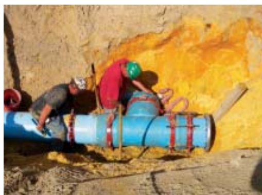
9,10, 11, 12,13: Construcción de zanjas para tuberías y losa en una planta desalinizadora por Ósmosis Inversa en el estado de la Florida, Estados Unidos. Construcción de muros que contendrán tuberías de alta presión. Instalaciones eléctricas para edificio con losa bajo nivel de la rasante. Construcción de estación de bombeo de concentrados. Instalación de la tubería de 16 pulgadas para descarga de concentrados. Instalación de tuberías de 30 pulgadas para captación de agua de mar.
