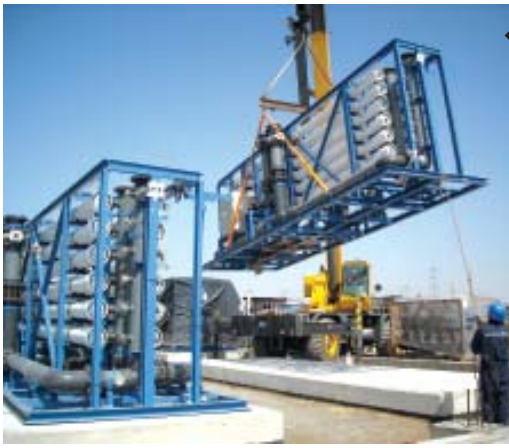
14, 15, 16: Instalación de bastidores con filtros de membranas semipermeables. Nueva planta de Hedera, (Israel) suministrará 127 millones de metros cúbicos de agua desalinizada, lo suficiente para abastecer al 20% de la población de Israel.
