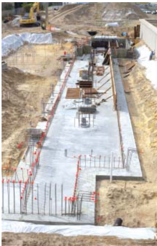
9,10, 11, 12,13: Construcción de zanjas para tuberías y losa en una planta desalinizadora por Ósmosis Inversa en el estado de la Florida, Estados Unidos. Construcción de muros que contendrán tuberías de alta presión. Instalaciones eléctricas para edificio con losa bajo nivel de la rasante. Construcción de estación de bombeo de concentrados. Instalación de la tubería de 16 pulgadas para descarga de concentrados. Instalación de tuberías de 30 pulgadas para captación de agua de mar.
