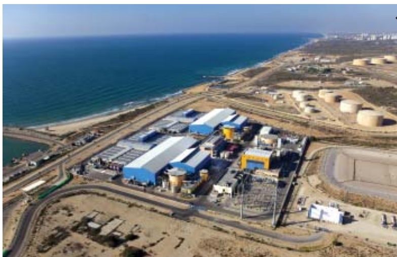
5, 6, 7: Planta desalinizadora de Osmosis Inversa. 8: Planta desalinizadora por evaporación Flash
